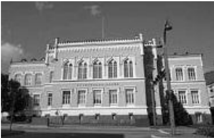
Jyväskylän lyseon vanha koulurakennus
